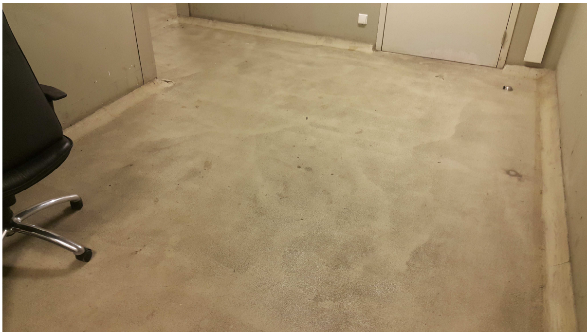
Fotografia nr 13 – Połączenie (wyoblenie, faseta) między posadzką a ścianami – korytarz techniczny
