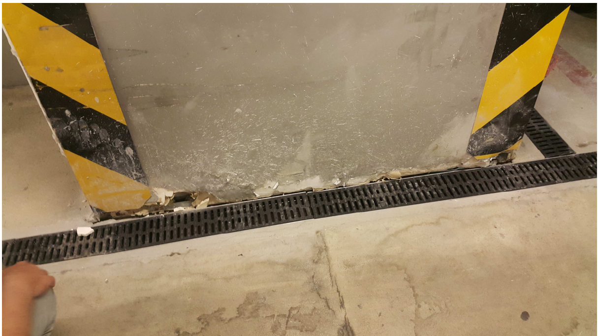
Fotografia nr 4 – Miejsce naprawy ściany (wycięcie płyty gipsowej, wykonanie wyoblenia między posadzką a ścianą – analogicznie jak przy pozostałych ścianach, uzupełnienie płyt GK i ewentualnie stelażu)
