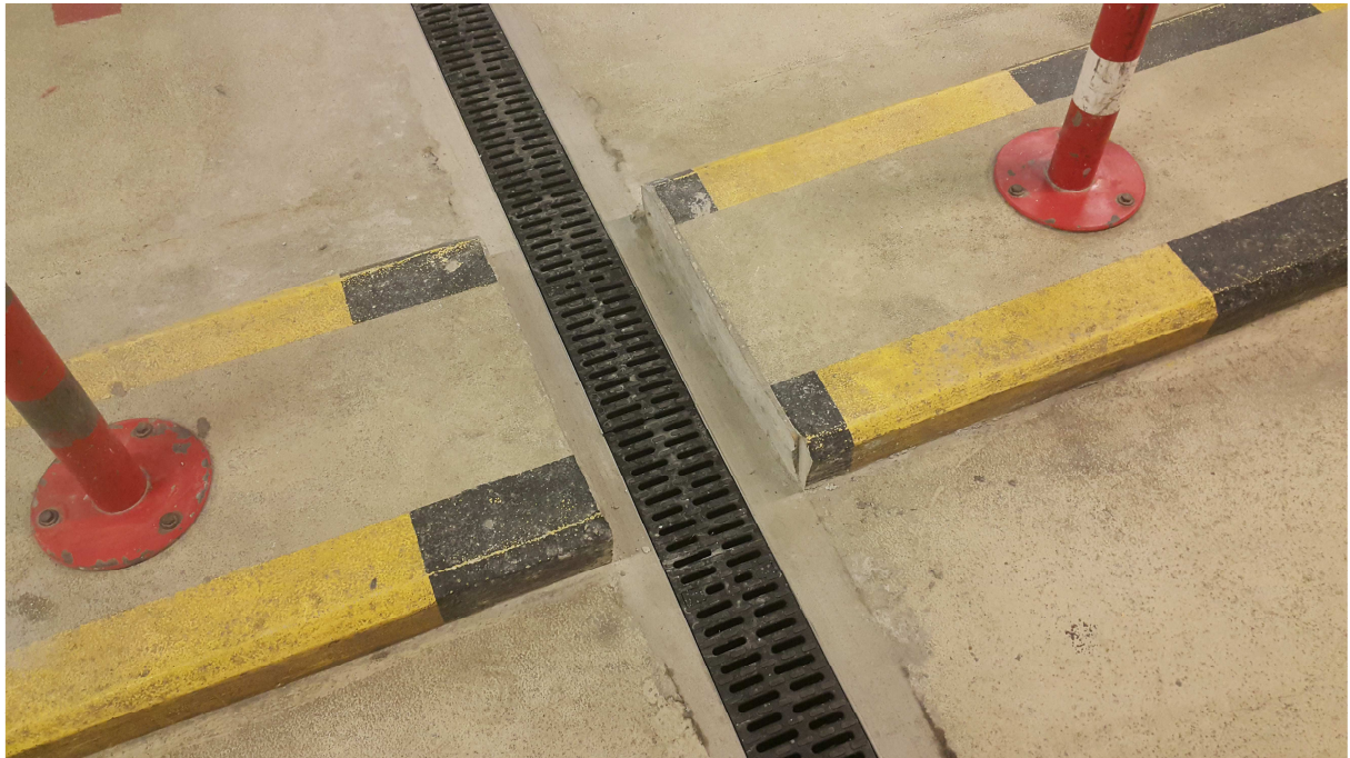
Fotografia nr 3 – Betonowe podwyższenie przy odwodnieniu do zfazowania – analogicznie do pozostałych podwyższeń
